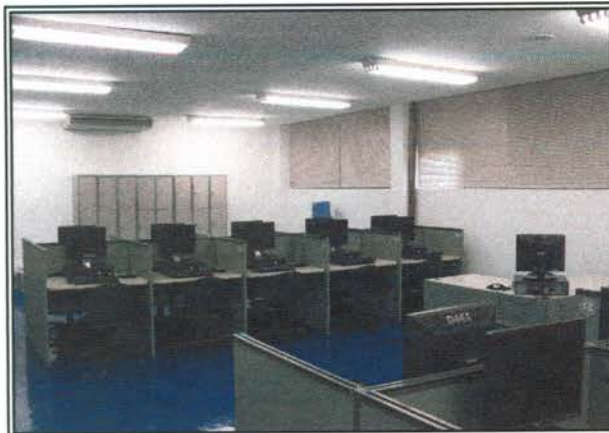
Supervisão/Central de Processamento de Dados
