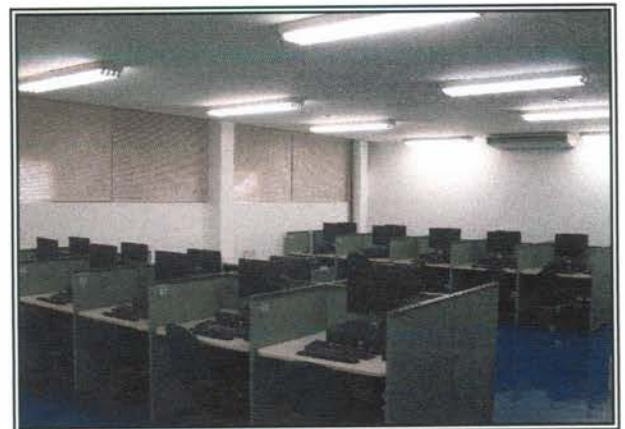
Central de Processamento de Dados
